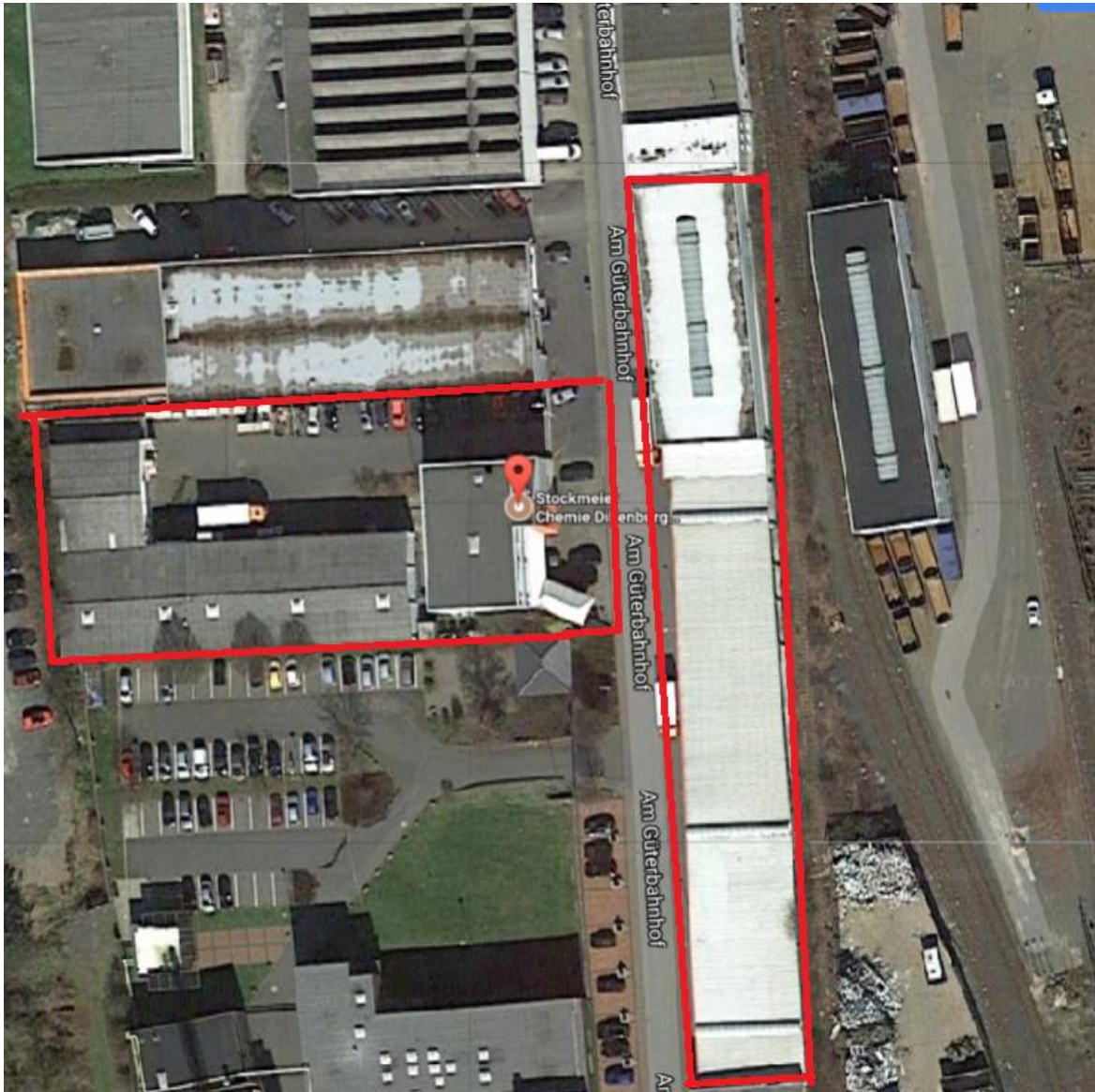
Übersichtsplan STOCKMEIER Chemie Dillenburg GmbH & Co. KG, NL Dillenburg Am Güterbahnhof 28 - 35683 Dillenburg 1
